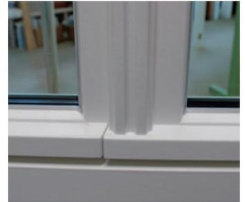
*I Eine interessante Eigenentwicklung: „Eingehängter“ und überdeckt verleimter Wetterschenkel aus Holz*
